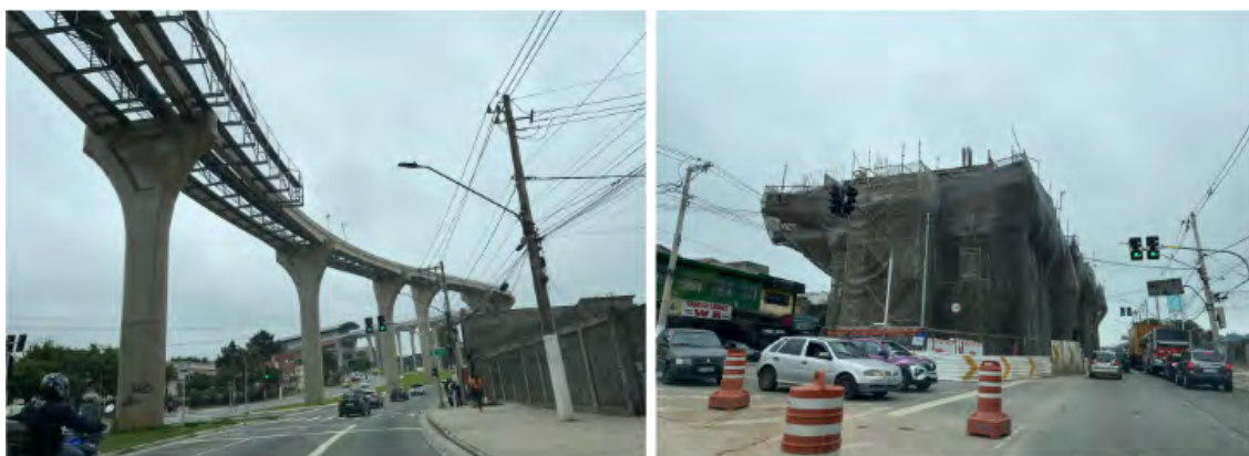
Figura 25: Obra do monotrilho na Avenida Ragueb Chohfi, em outubro de 2023.
