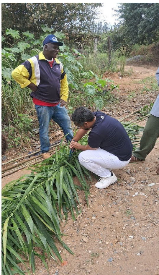
Figura 50 – Marcos orientando Thiago Hideo na construção do arco
