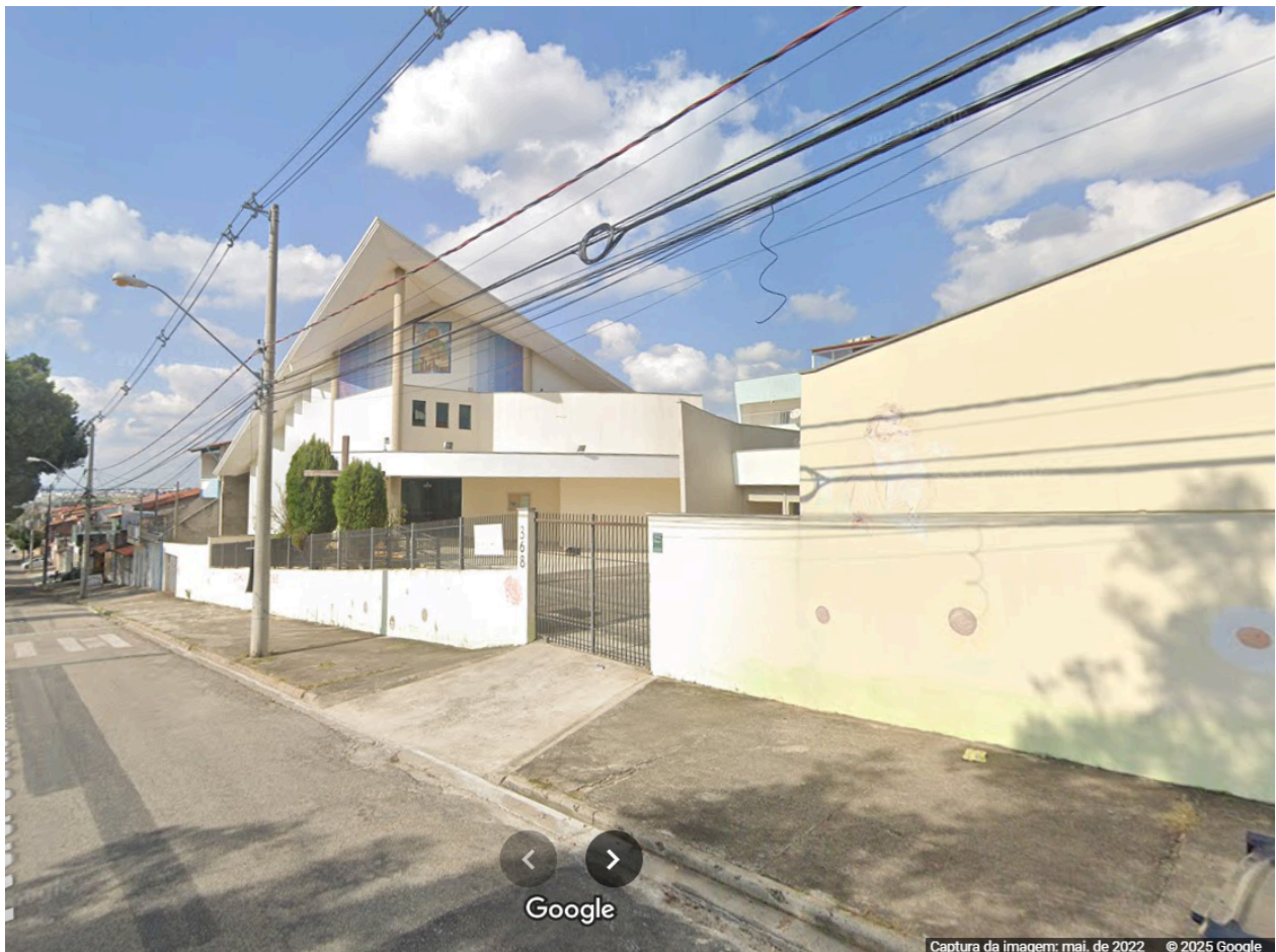
Fotografia 11 - Fachada da Comunidade São José - Sorocaba/SP
