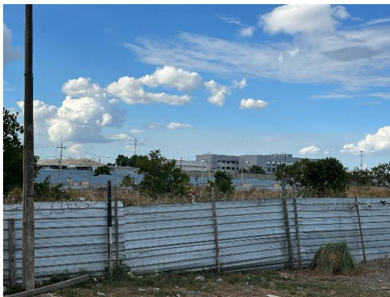
Figura 20 - Tapumes utilizados para delimitar a área do abrigo.
