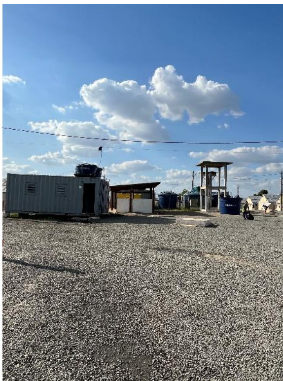
Figura 15 - Vista de um dos banheiros e da área de lavagem de roupas.
