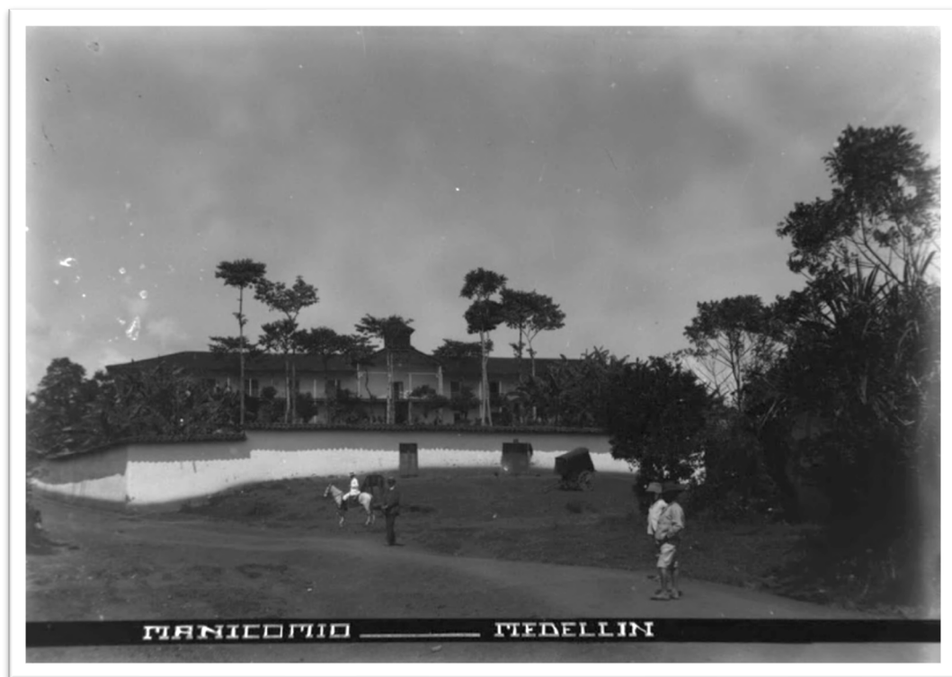
Fotografía 13 – Vista general del Manicomio, 1916.
