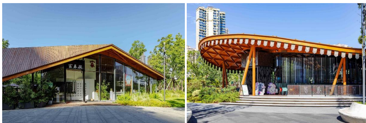
Figura 99 – Casa de Telhas e a Casa de Waffle
