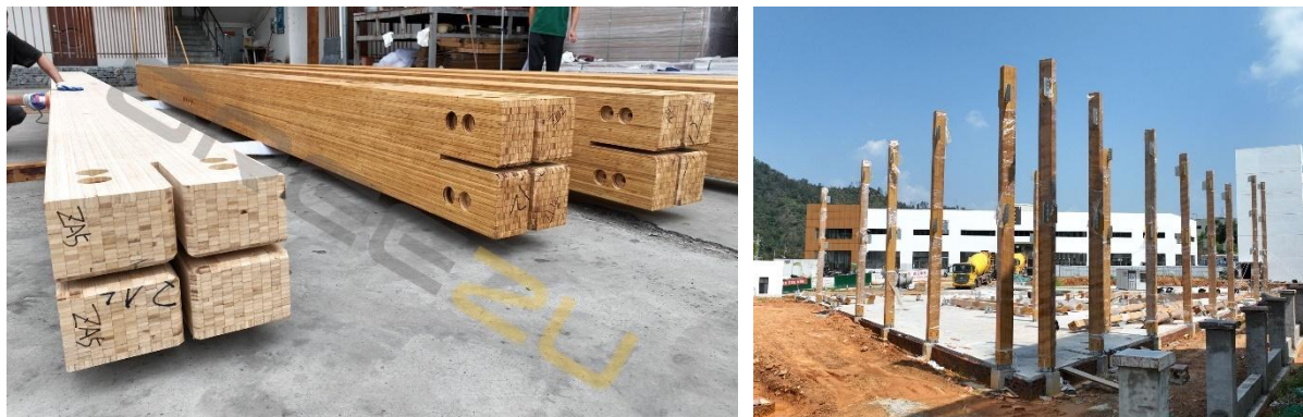
Figura 125 – Construção do Edifício da Greezu
