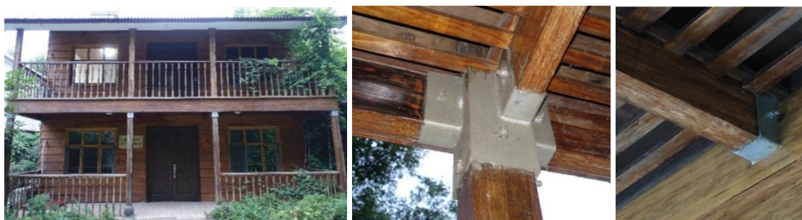
Figura 11 - Edifício de bambu resistente a terremotos na Universidade Florestal de Nanjing
