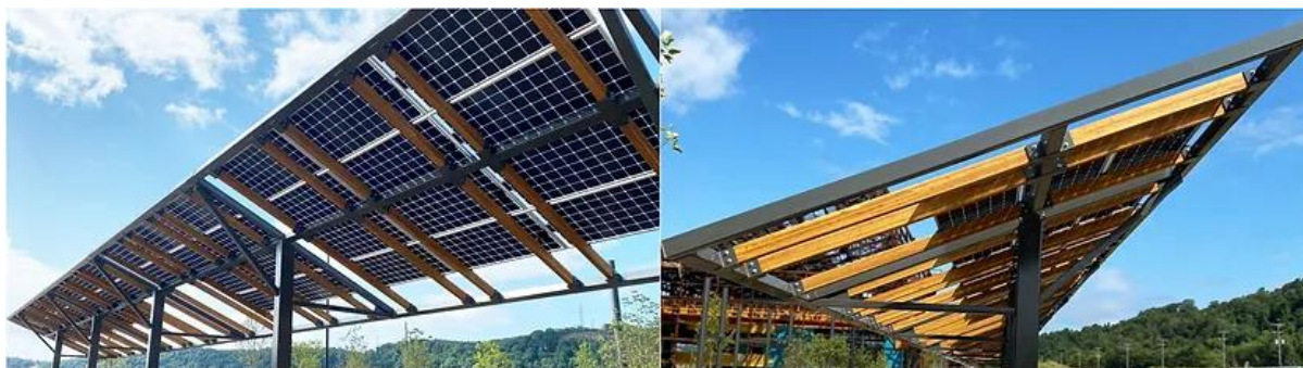
Figura 127 – Novo Projeto com Lamboo® Structure™
