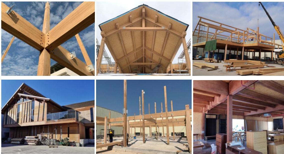
Figura 10 - Construção de um edifício de dois andares com LBL na China
