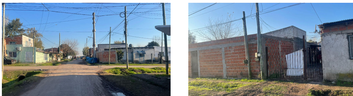
Figura 46: Conexões regulares de energia elétrica
