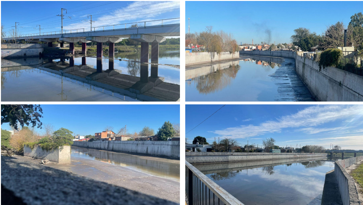
Figura 64: Vista do muro de contenção no Córrego El Gato
