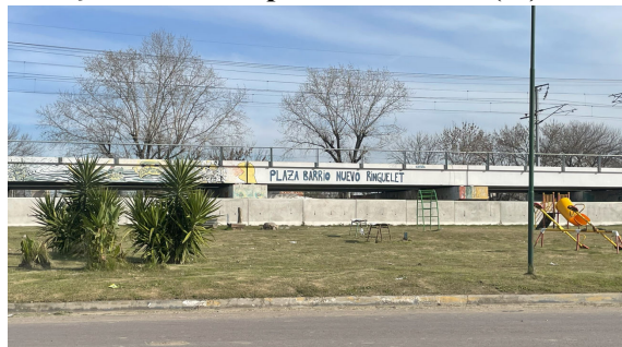
Figura 72: Praça construída pelos moradores(as) do Barrio Nuevo
