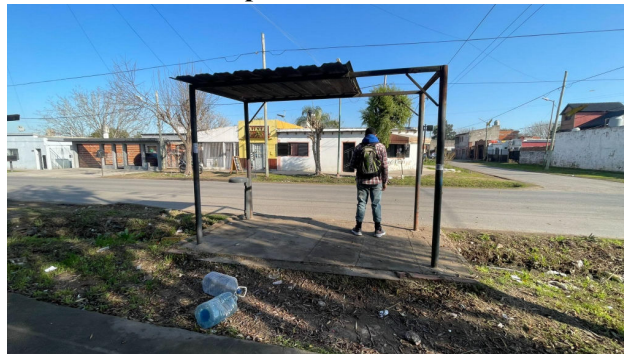
Figura 42: Estrutura do ponto de ônibus em Puente de Fierro
