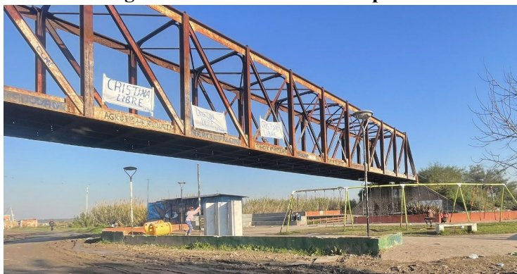
Figura 29: Estrutura ferro da ponte
