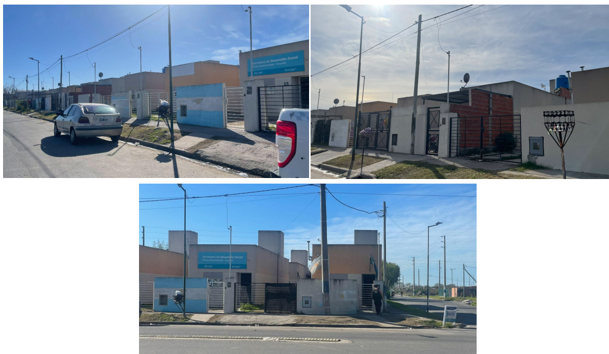
Figura 73: Segurança, Centro de Saúde, Desenvolvimento Social e casas da Municipalidade do Barrio Nuevo
