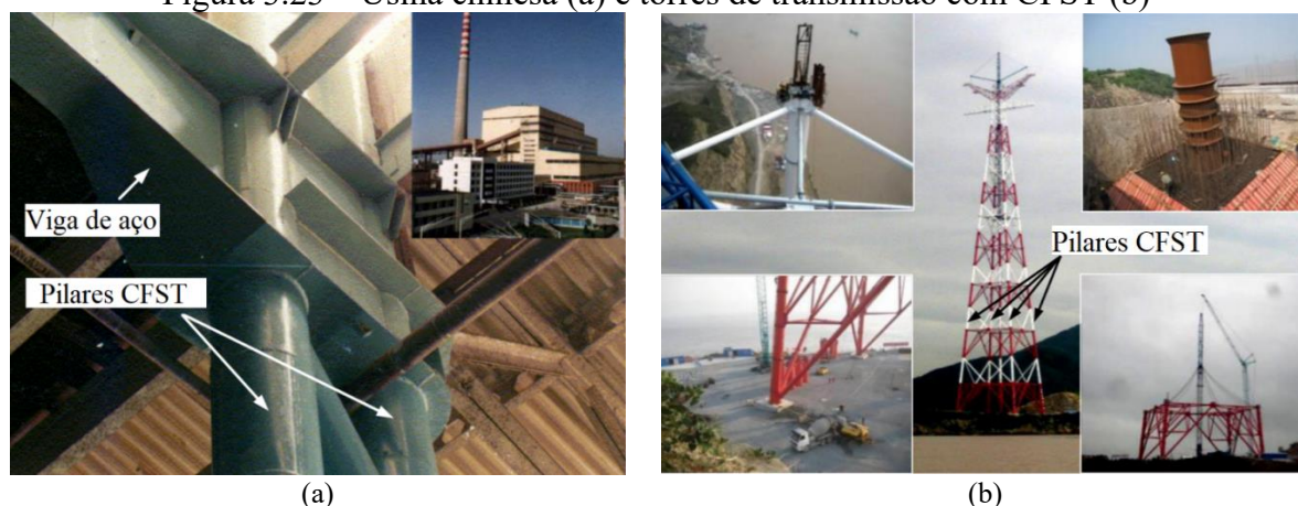
Figura 3.23 – Usina chinesa (a) e torres de transmissão com CFST (b)
