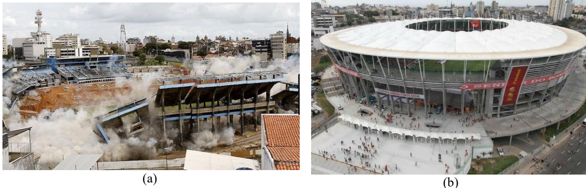
Figura 2.15 – Demolição da antiga Arena Fonte Nova (a) e Arena Fonte Nova atualmente (b)
