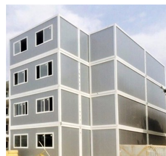
Figura 5 - Construção de um edifício modular completo
