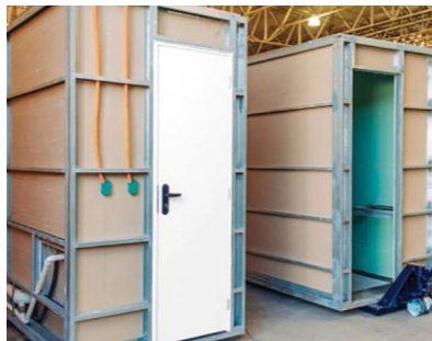
Figura 3 - Construção Volumétrica Offsite de um Pod
