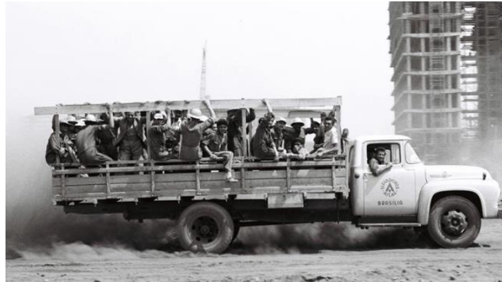
Figura 5: Candangos na construção do Congresso.
