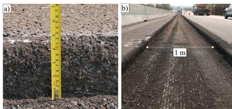
Figura 3.14 – Condições pós-fresagem: a) espessura da camada; b) faixa fresada (Autora, 2026).
