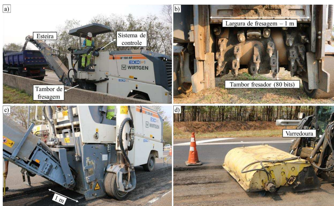
Figura 3.13 – Fresagem: a) fresadora; b) tambor de fresagem; c) etapas da fresagem; d) limpeza da superfície pós fresagem (Autora, 2026).
