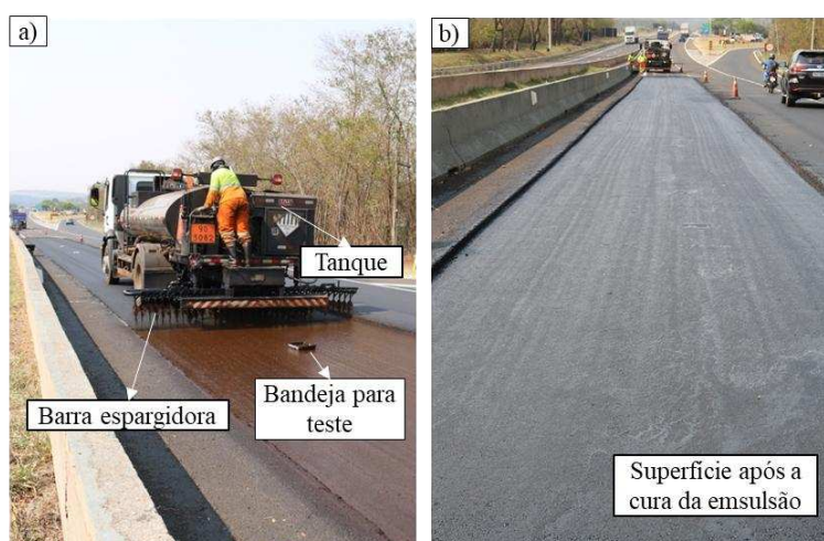
Figura 3.18 – Procedimento de aplicação da pintura de ligação no segmento experimental: a) aspersão da pintura de ligação; b) superfície após a cura da emulsão (Autora, 2026).
