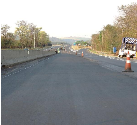
Figura 3.23 – Segmento experimental de campo após a construção (Autora, 2026).
