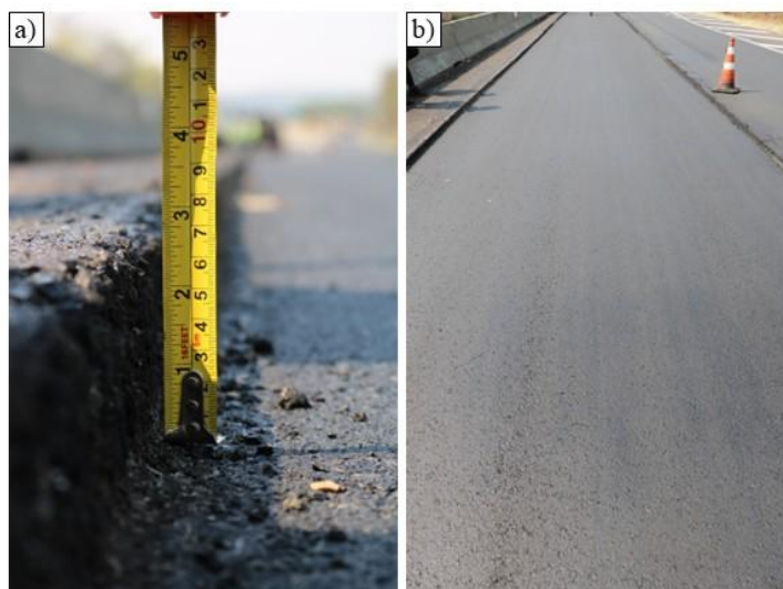
Figura 3.17 – Condições pós-compactação da camada asfáltica inferior: a) espessura da camada; b) camada final compactada (Autora, 2026).
