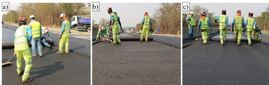
Figura 3.19 – Procedimento de instalação dos reforços no segmento experimental: a) G-PET; b) G-PVA; c) G-FV (Autora, 2026).
