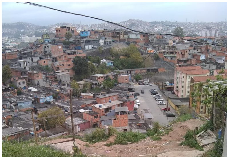
Imagem 04 - Prédios amarelos da CDHU à direita
