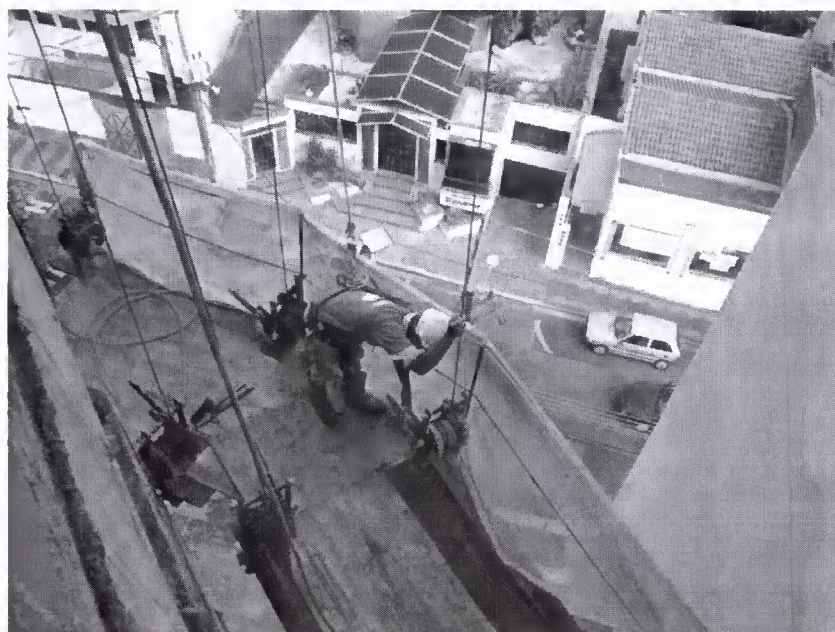
Figura 3. Emprego de força física na operação do andaime suspenso não motorizado
