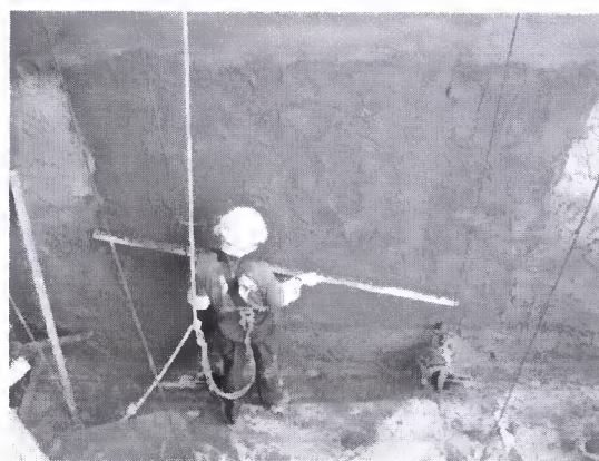
Figura 12. Sarrafeamento da argamassa
