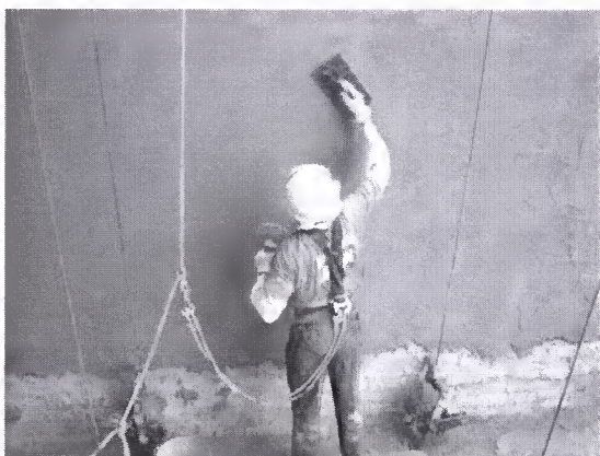
Figura 13. Desempeno da superfície
