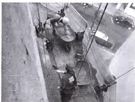
Figura 7. Preparo da base (estrutura)
