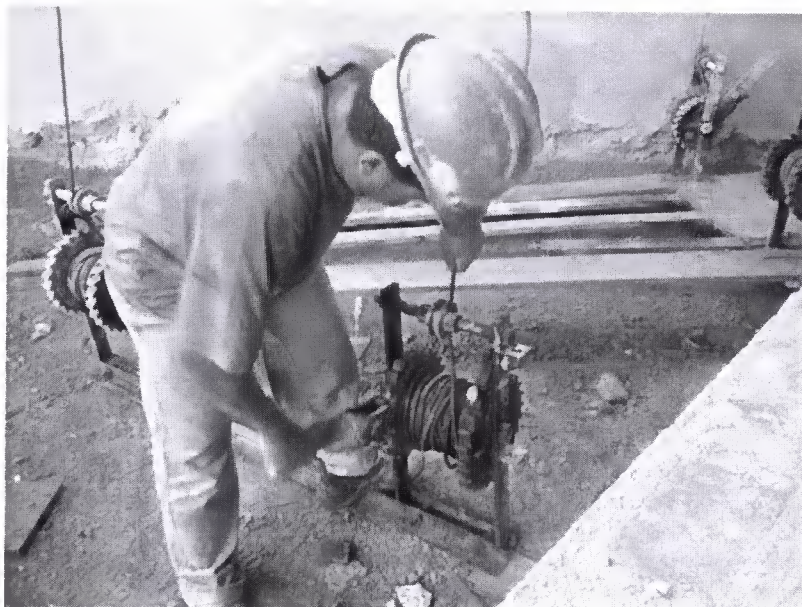
Figura 18. Operário trabalhando na montagem do andaime suspenso
