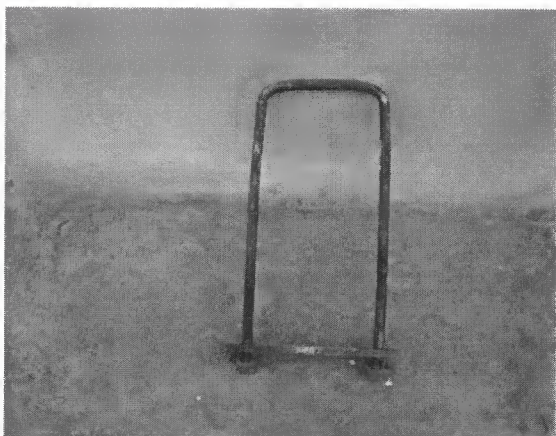
Figura 54. Detalhe do grampo de fixação do perfil à estrutura
