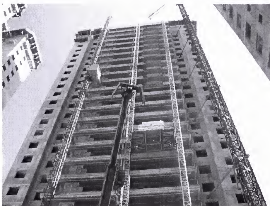
Figura 27. Plataforma com movimentação vertical em pinhão e cremalheira Fonte: Amadio (2005)
