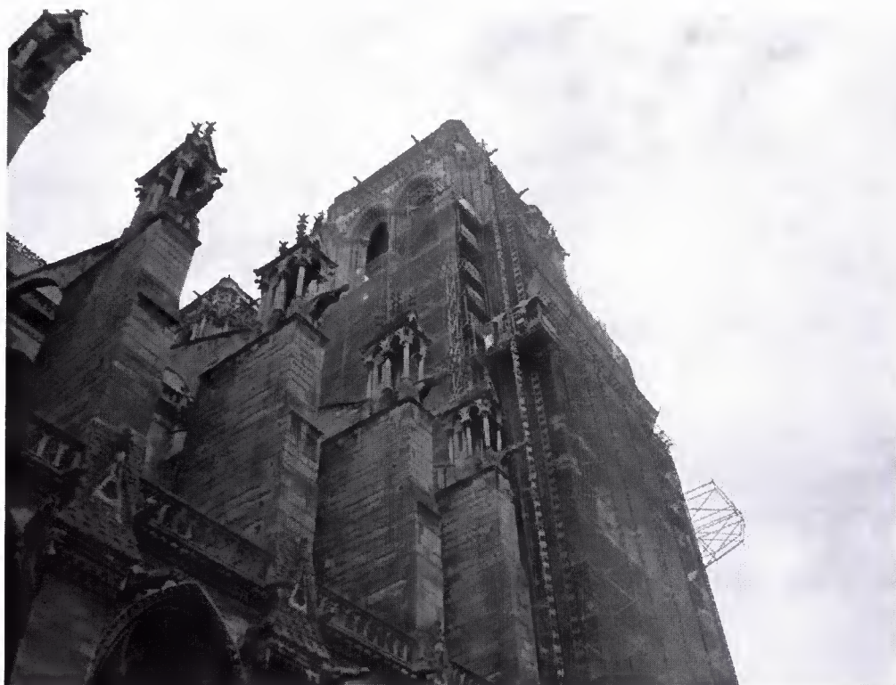
Figura 26. Andaime fachadeiro associado a elevador por cremalheira em serviços na Catedral de Notre Dame – Paris – 2005
