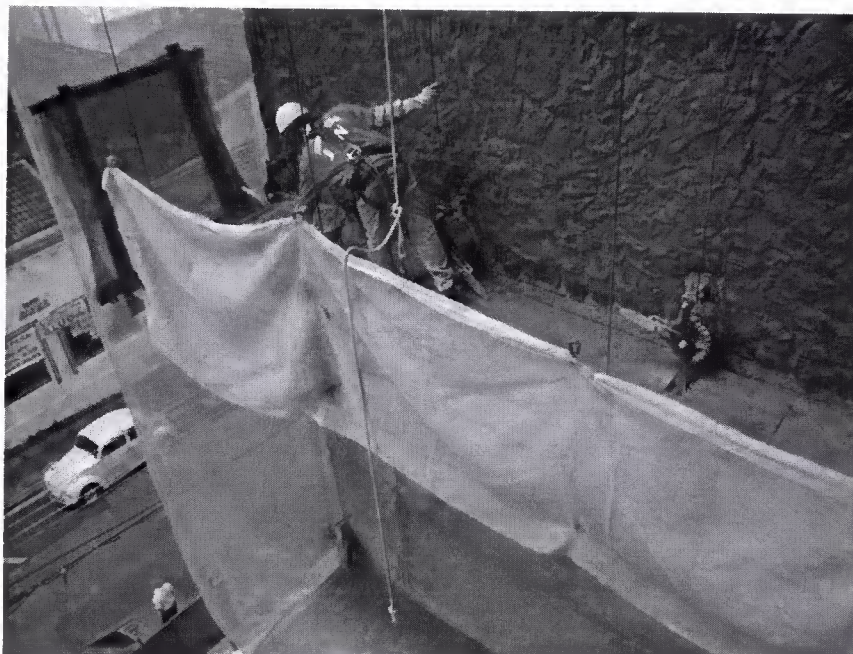
Figura 28. Operário em andaime suspenso
