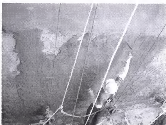
Figura 11. Aplicação de argamassa
