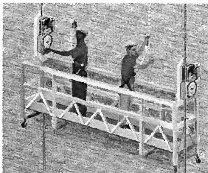
Figura 65. Andaime suspenso de 2 pontos
