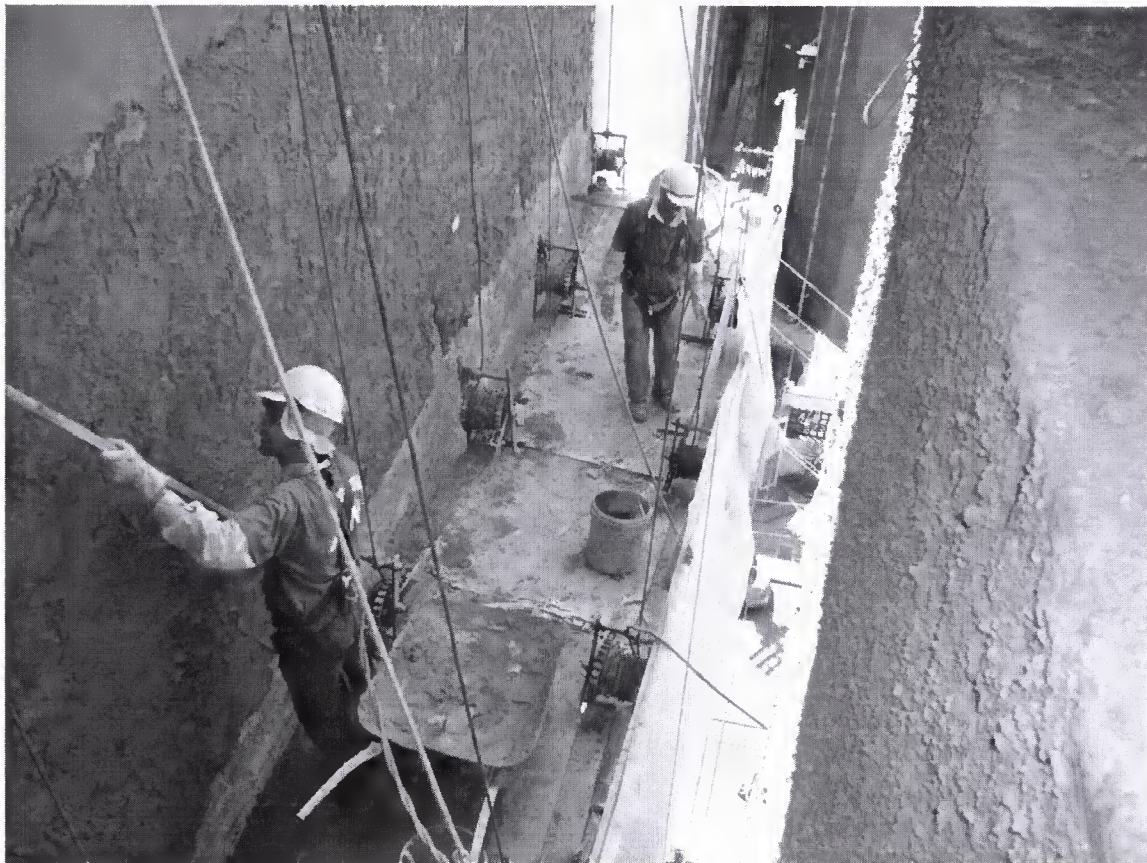
Figura 36. Vista de segmento de andaime suspenso pesado
