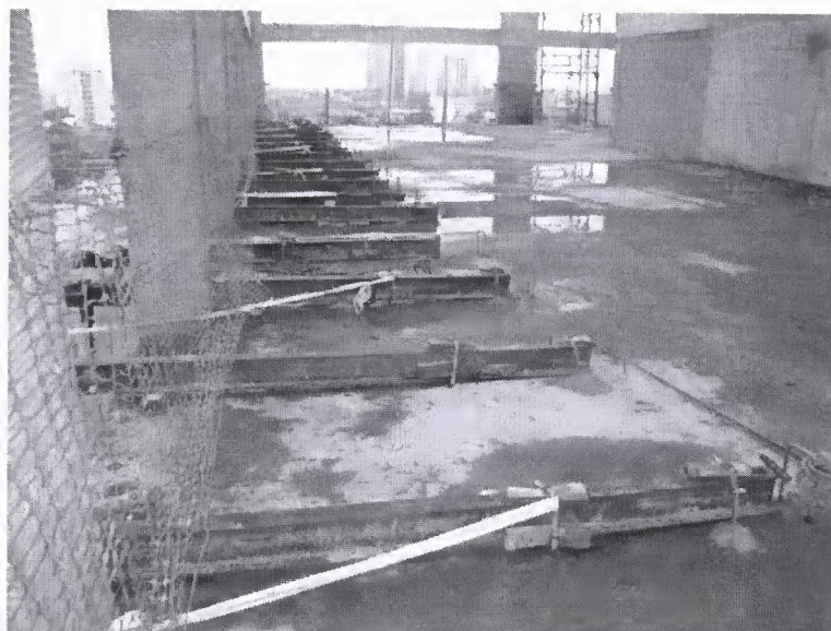
Figura 73. Disposição das vigas de sustentação
