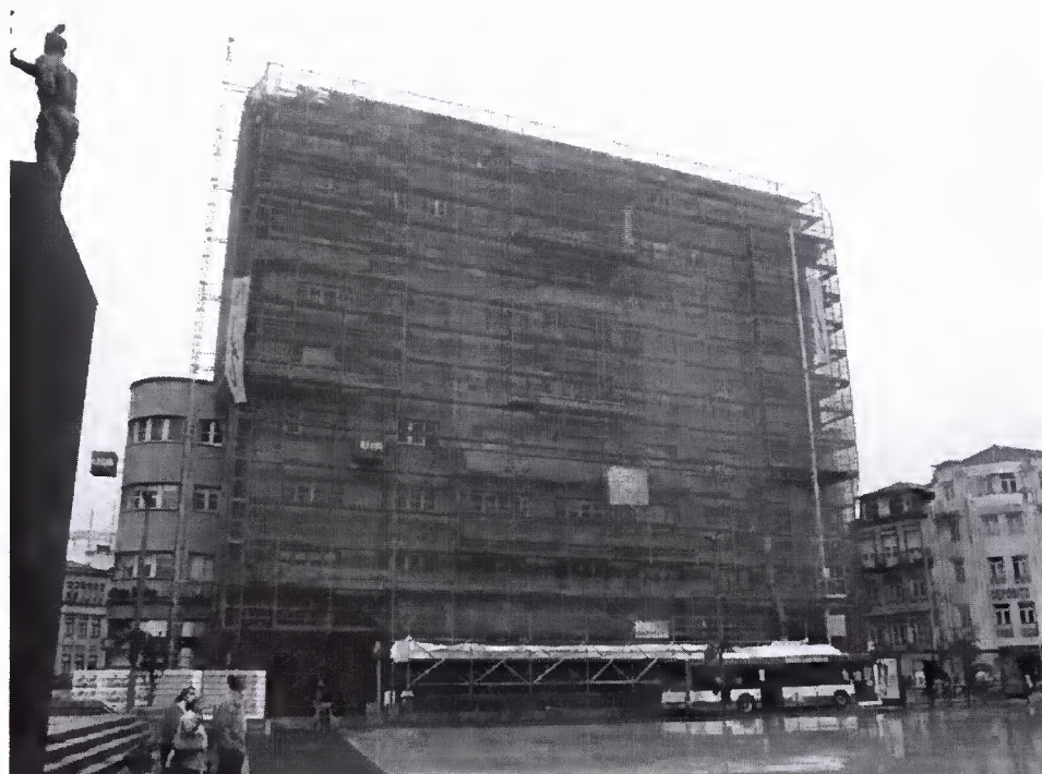
Figura 25. Andaime fachadeiro na cidade do Porto – Portugal - 2005
