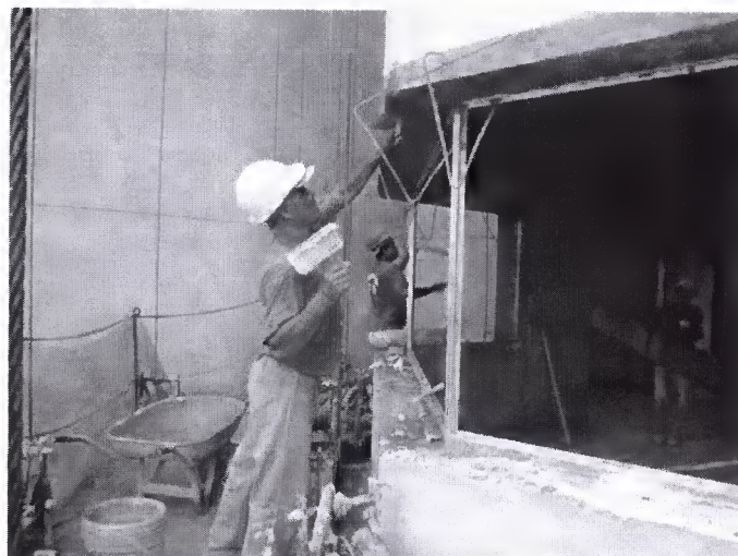
Figura 17. Execução de requadro do revestimento junto às esquadrias
