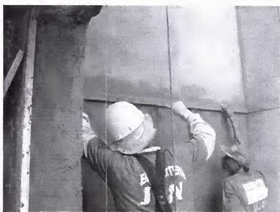
Figura 15. Execução de junta
