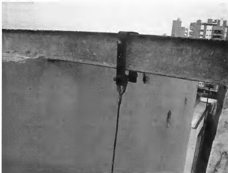
Figura 59. Detalhe de fixação do cabo de aço à viga de sustentação
