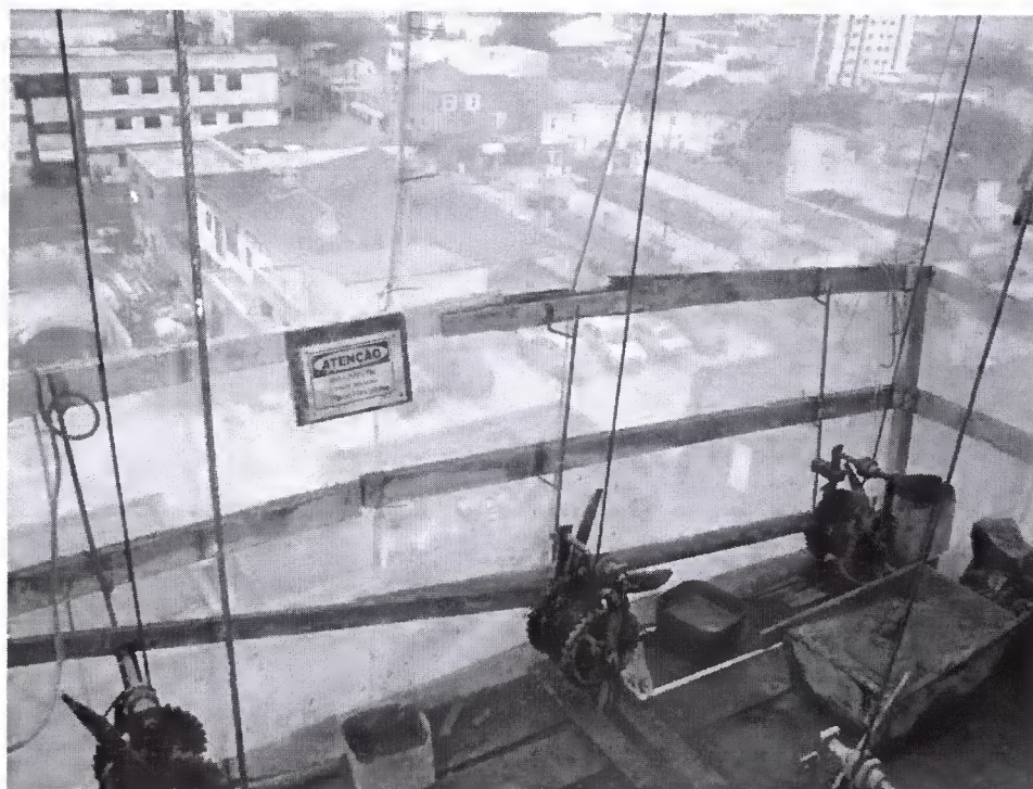
Figura 72. Detalhe da tela de fechamento do guarda-corpo.
