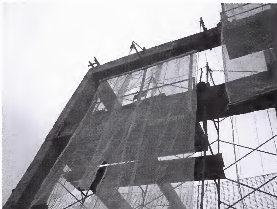
Figura 71. Vista do local de sustentação do andaime suspenso leve.
