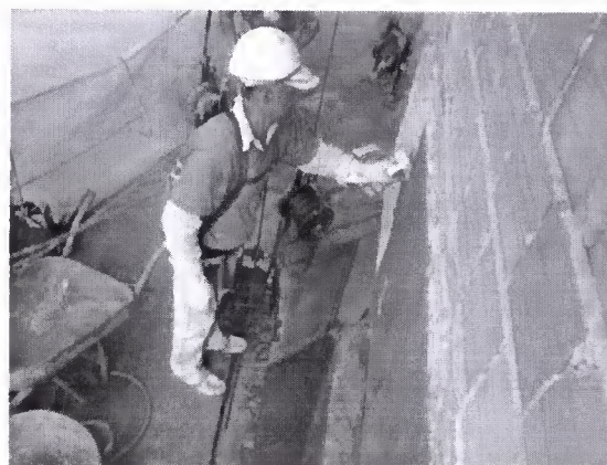
Figura 8. Preparo da base (alvenaria)
