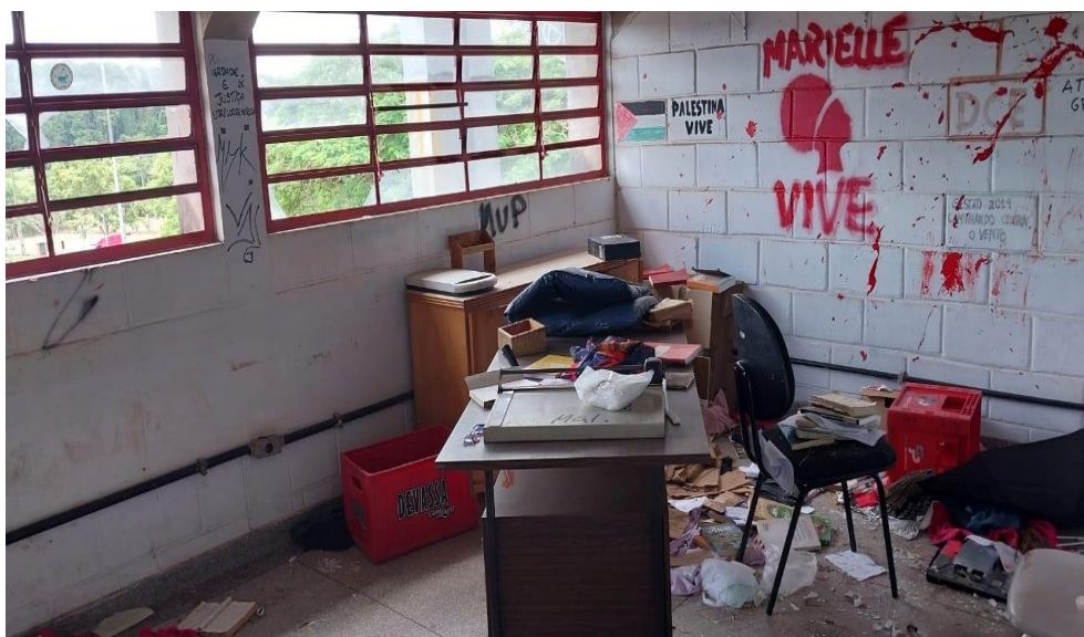
Imagem 22 - Sala da Prédio DCE Livre- arrombada - foto de fevereiro de 2025
