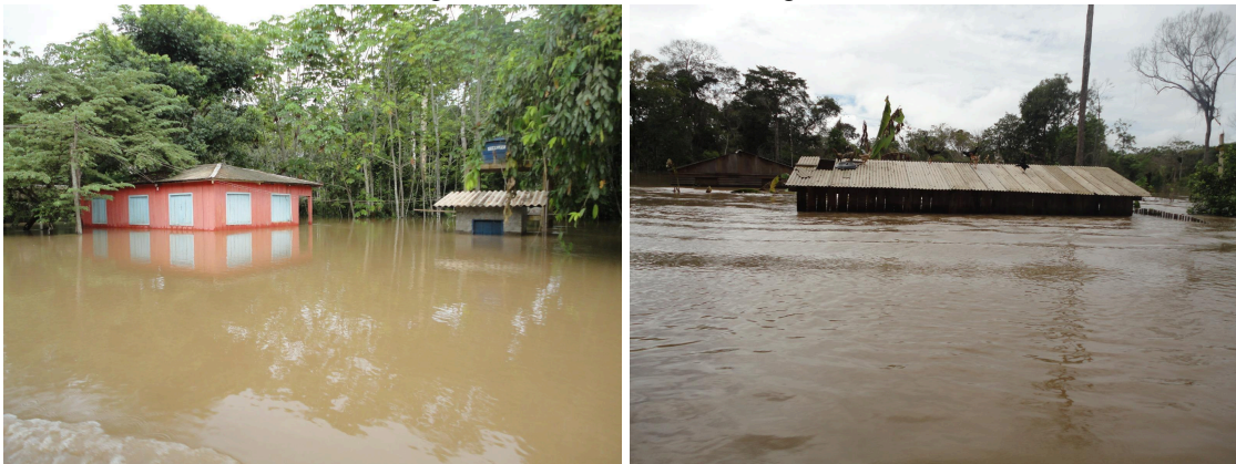
Figura 16 – Fachada de casa alagada.
