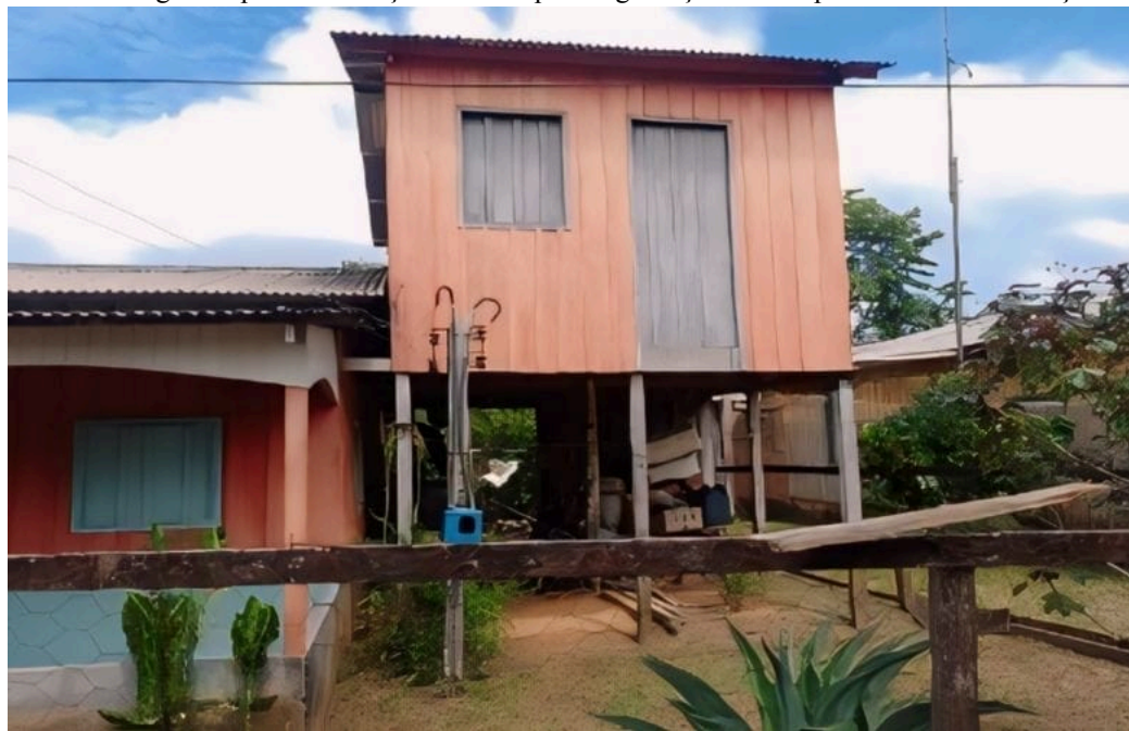
Figura 25 – Casa erguida após a inundação de 2014 para segurança em uma possível nova inundação.
