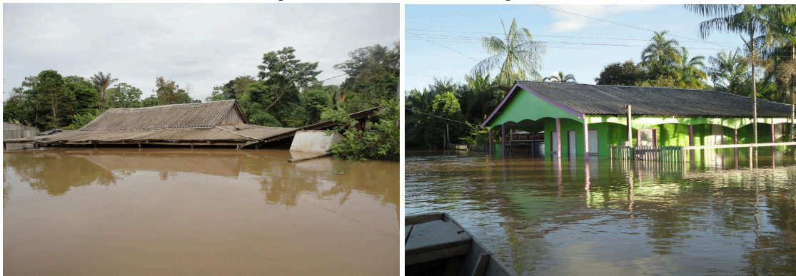
Figura 15 – Fachada de casa alagada.
