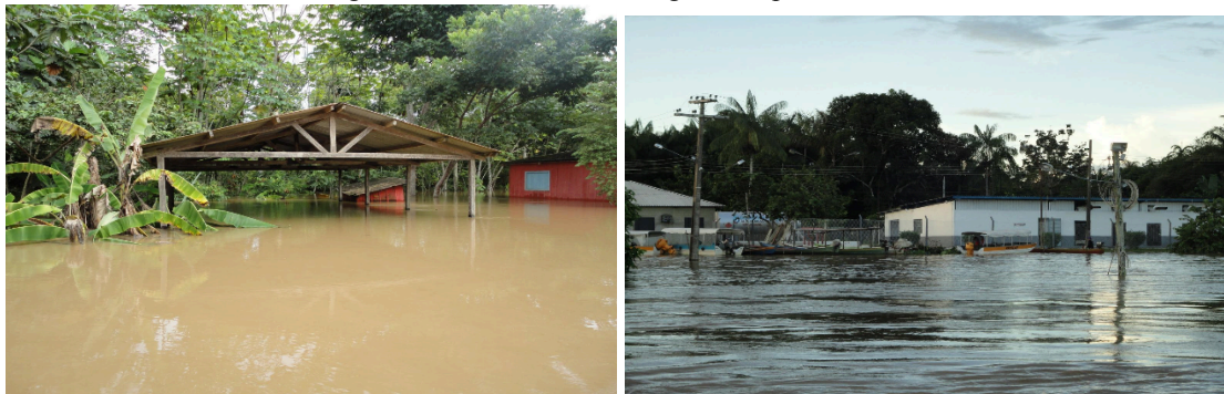
Figura 17 – Casa e escola alagada, respectivamente.
