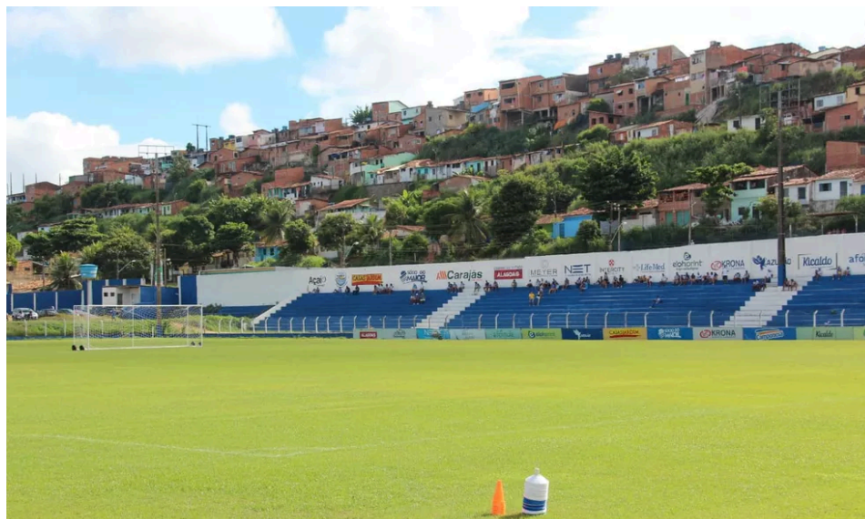
Figura 8: Arquibancadas do estádio do Mutange com barreira ao fundo
