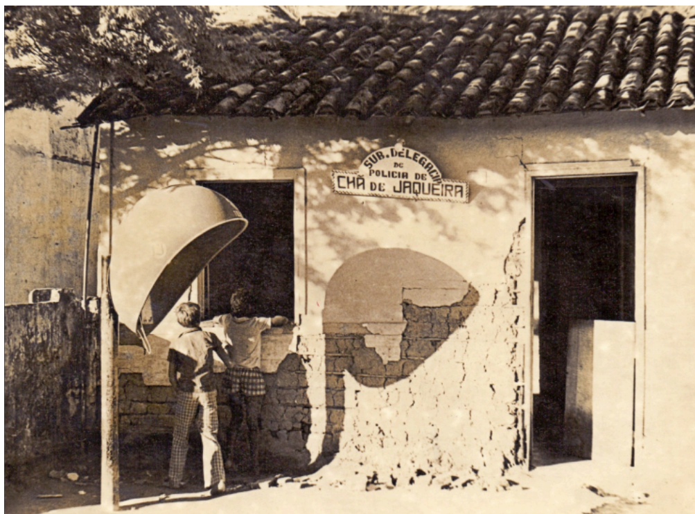
Figura 17: Prédio da sub-delegacia da Chã da Jaqueira no final da década de 1970
