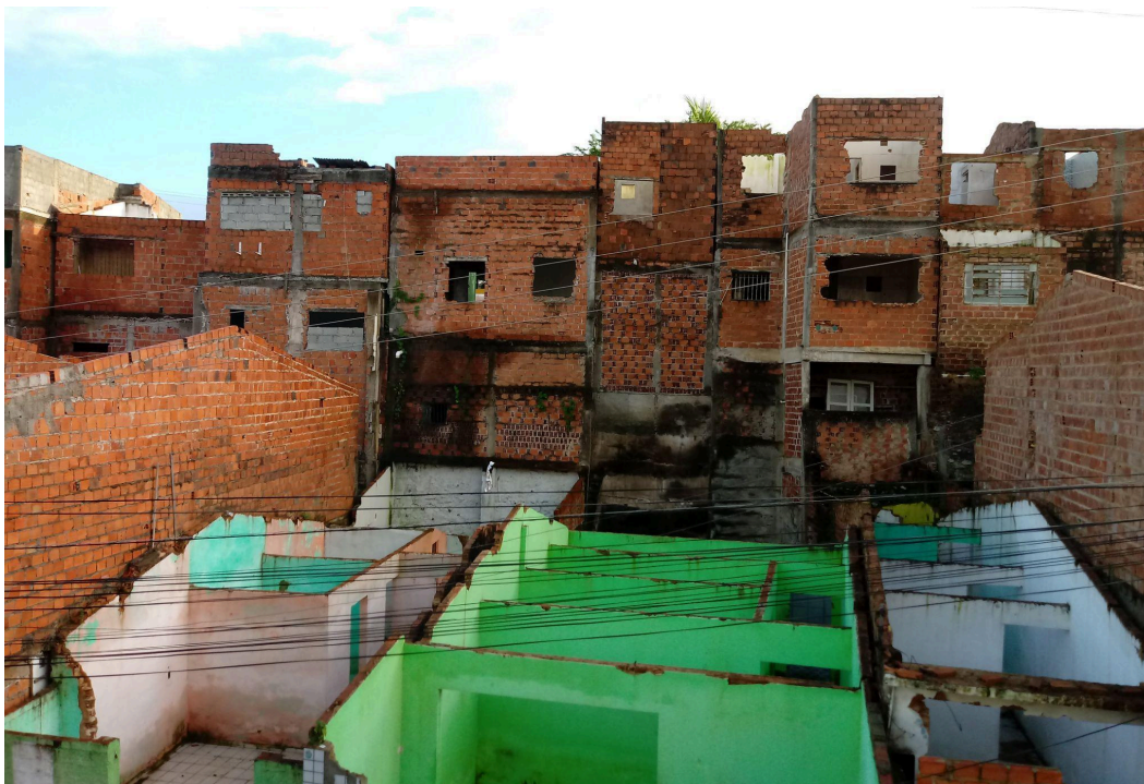
Figura 25: Escombros da mineração em Bebedouro
