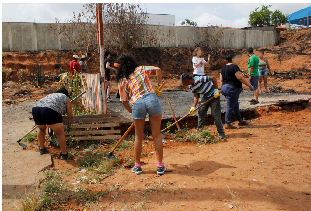
Figura 8 - Moradores e voluntários em mutirão de limpeza e reconstrução da área acometida pelo incêndio. Fonte: acervo pessoal.
