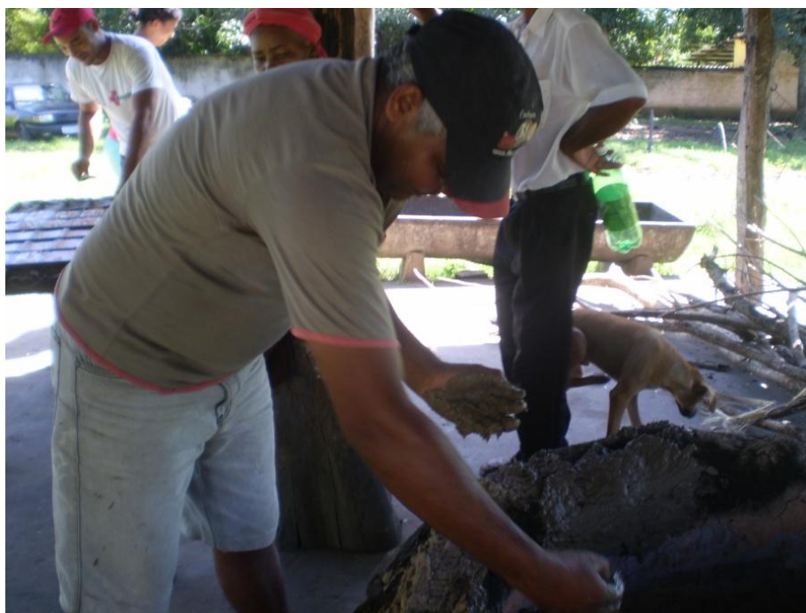
Figura 25 Trabalho de reparo de uma fornalha com argila obtida na baixa, próxima do rancho onde a rapadura é produzida.
