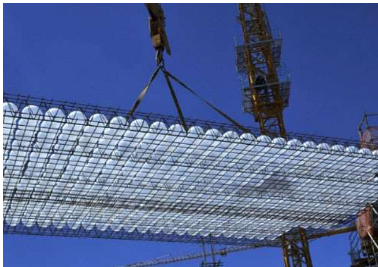
Figura 9 - Módulos da laje bubbledeck
