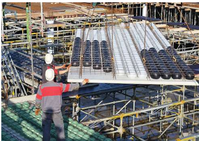
Figura 10 – Painel pré-moldado de laje bubbledeck
