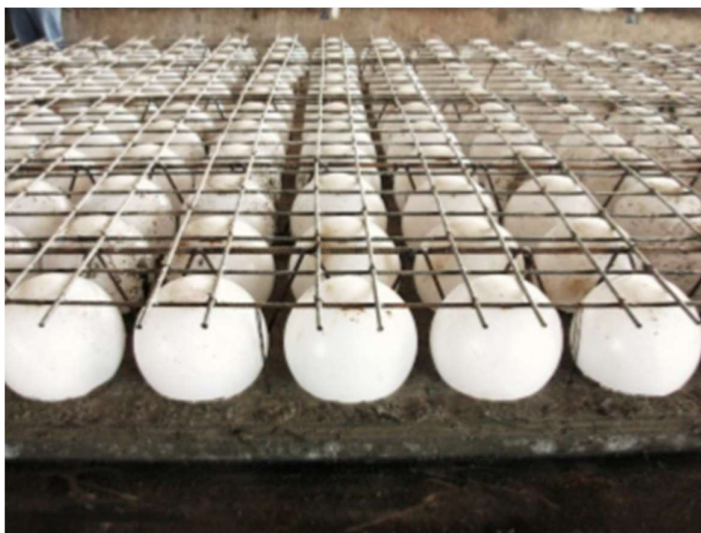
Figura 2 – Sistema de laje bubbledeck em montagem
