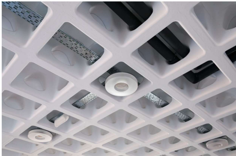
Figura 3 – Sistema de laje holedeck finalizado
