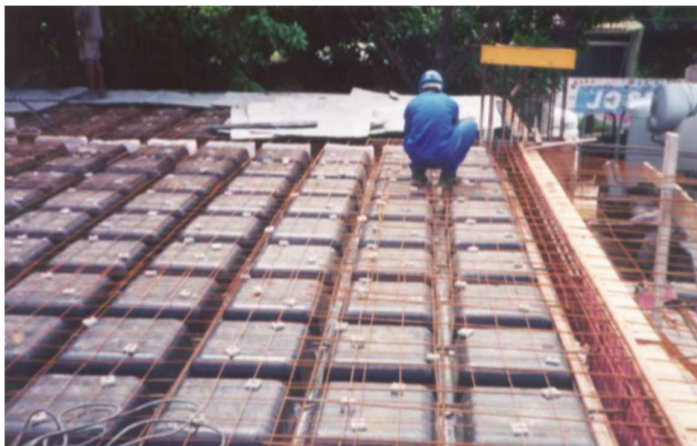
Figura 1 – Montagem de uma laje nervurada com cubas plásticas
