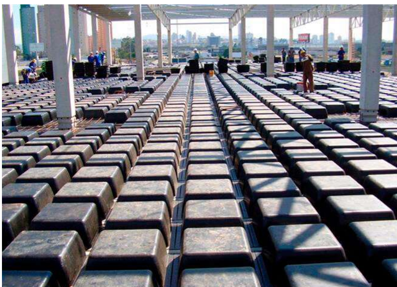
Figura 6 – Posicionamento de cubetas laje nervurada
