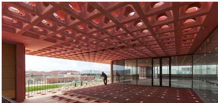
Figura 12 – Laje holedeck finalizada
