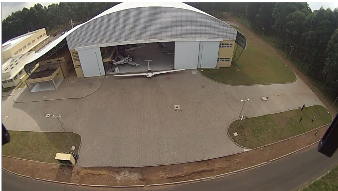
Figura 4- Vista aérea do hangar IFSP – São Carlos.
