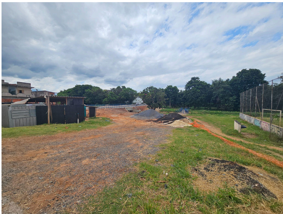
Figura 12 - Obras de ligação entre a avenida Ulysses Guimarães e a avenida Olinda Aires Paulete.
