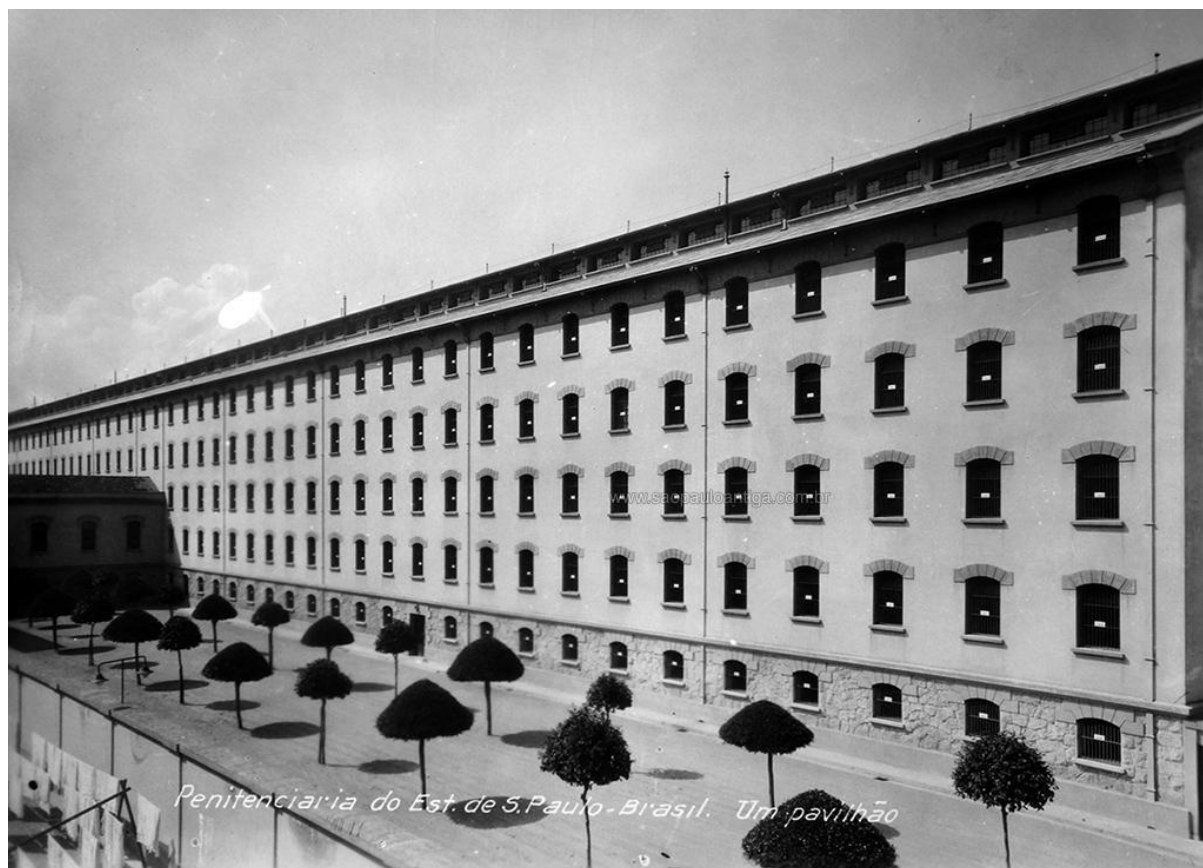
Figura 4 - Fotografia de um dos pavilhões da Penitenciária do Estado de São Paulo na década de 1920.
