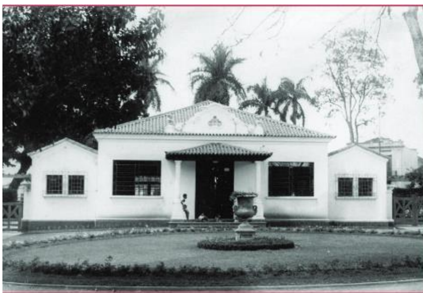
Figura 1 - Fachada do prédio original “Parque Infantil Cambuí”.
