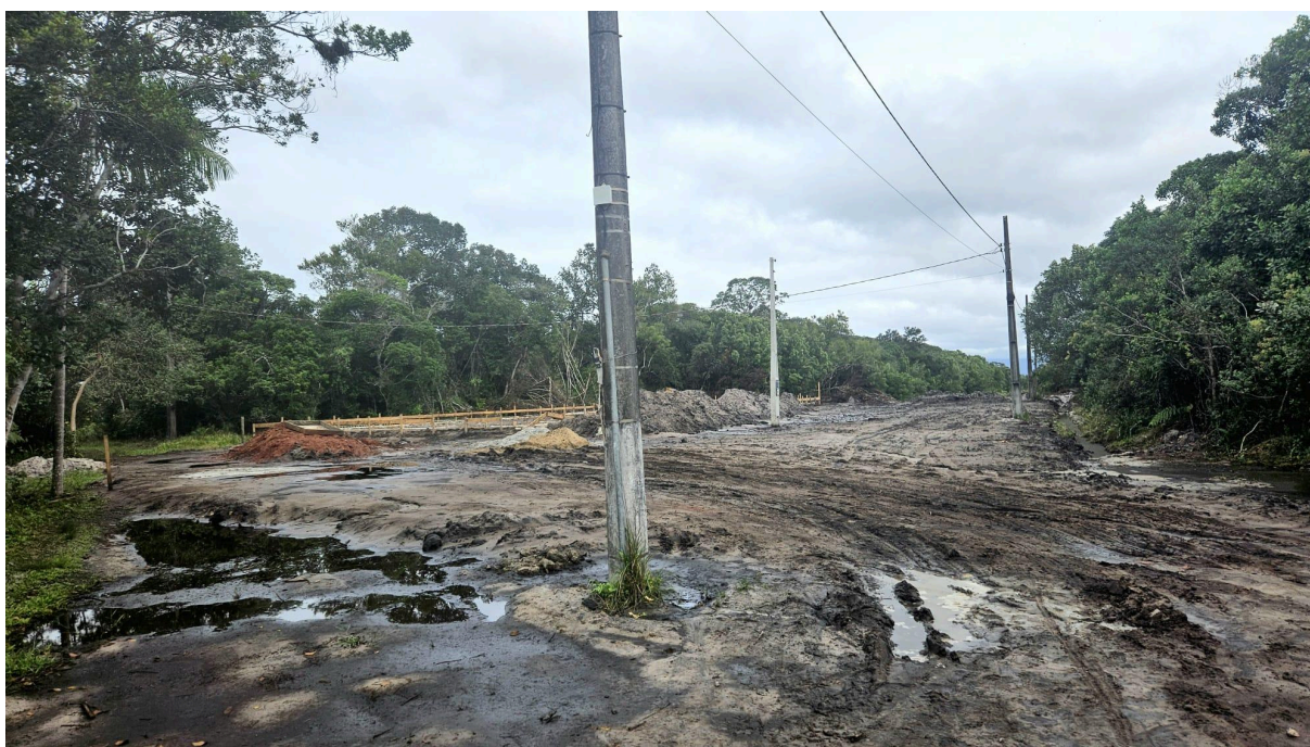
Imagem 12 – Registros da construção da escola em fase inicial (Arquivo pessoal. Julho de 2024).
