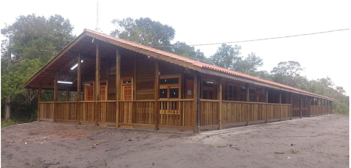
Imagem 13 – Nova escola de Nhamandu Mirim, no estágio final de construção (Arquivo pessoal. Setembro de 2025).
