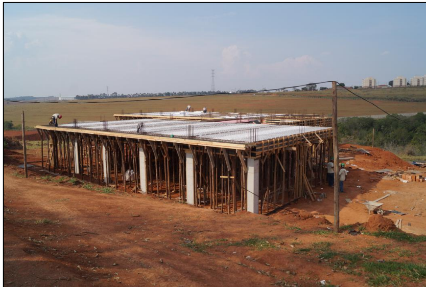
Figura 11 - Montagem das lajes treliçadas
