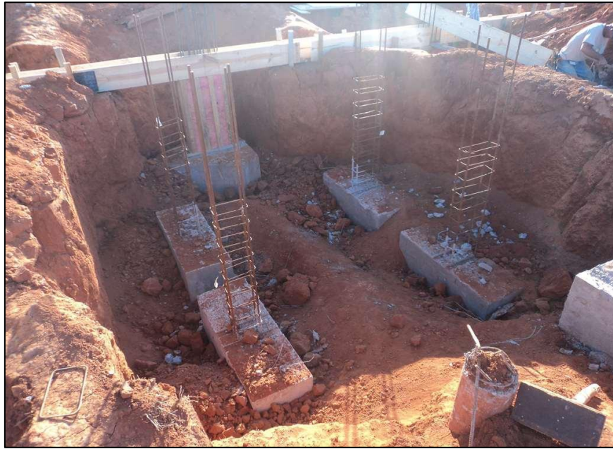
Figura 10 - Blocos de fundação
