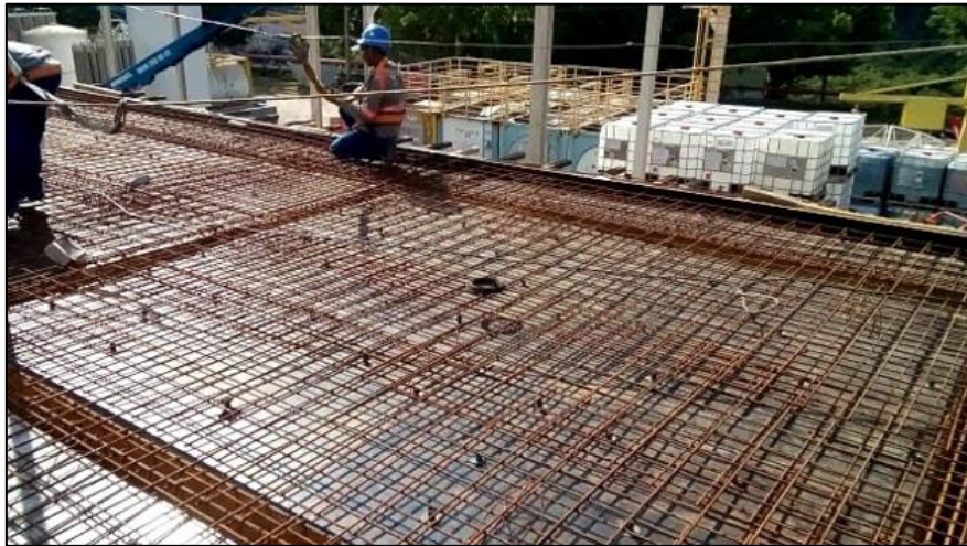
Figura 2 - Armação laje maciça
