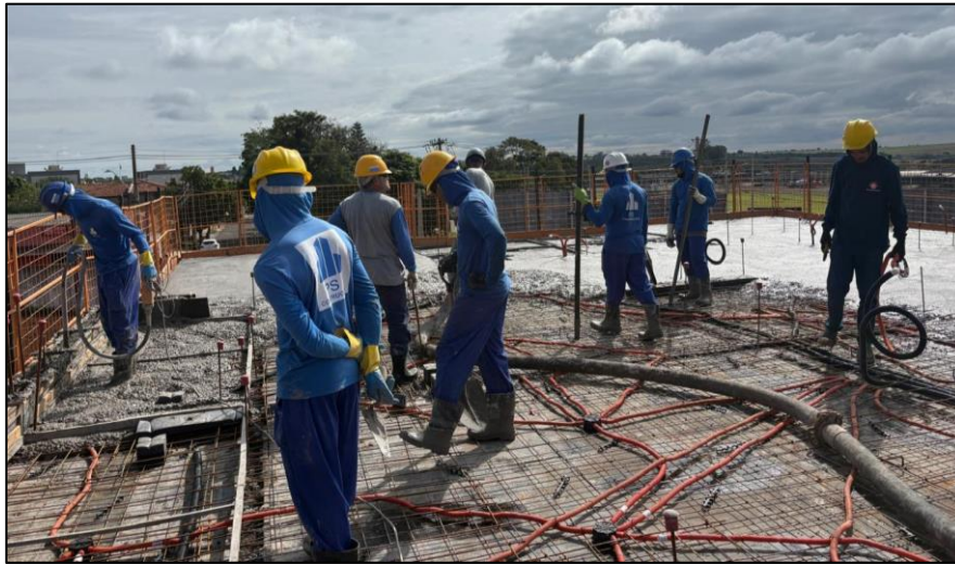
Figura 3 - Concretagem de laje maciça
