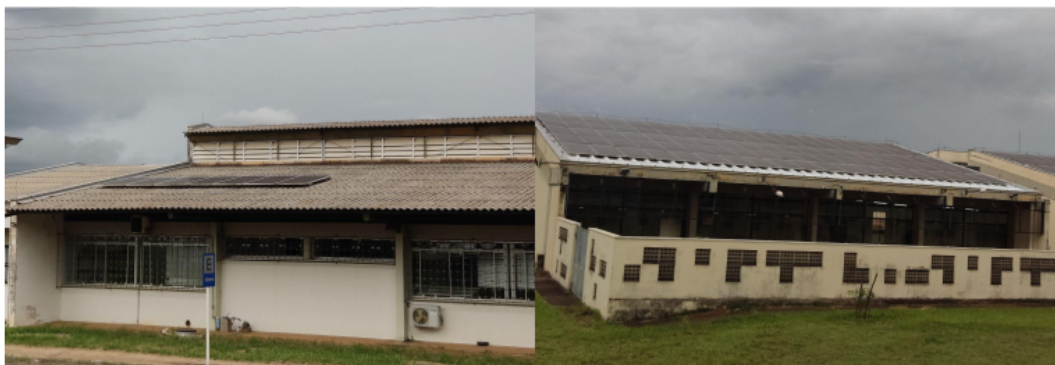
Figura 23 - Fotografias de usinas fotovoltaicas instaladas na área norte da UFSCar
