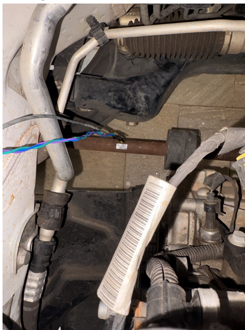
Figura 38 – Instalação do sensor Hall A3144 e ímã no semieixo
