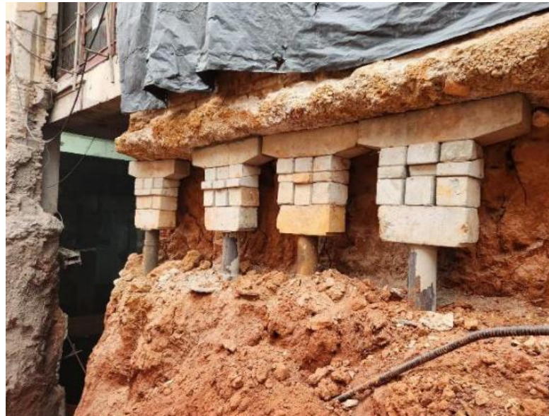
Figura 14 – Detalhe dos blocos com acunhamento realizado.
