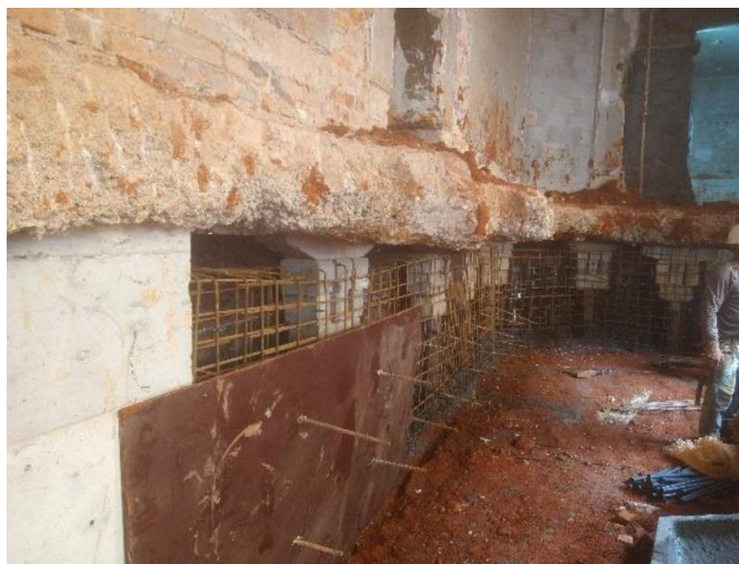
Figura 16 – Incorporação das estacas de reação em parede de concreto.
