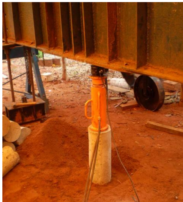
Figura 39 – Prensagem das estacas tipo mega de concreto com macaco hidráulico.
