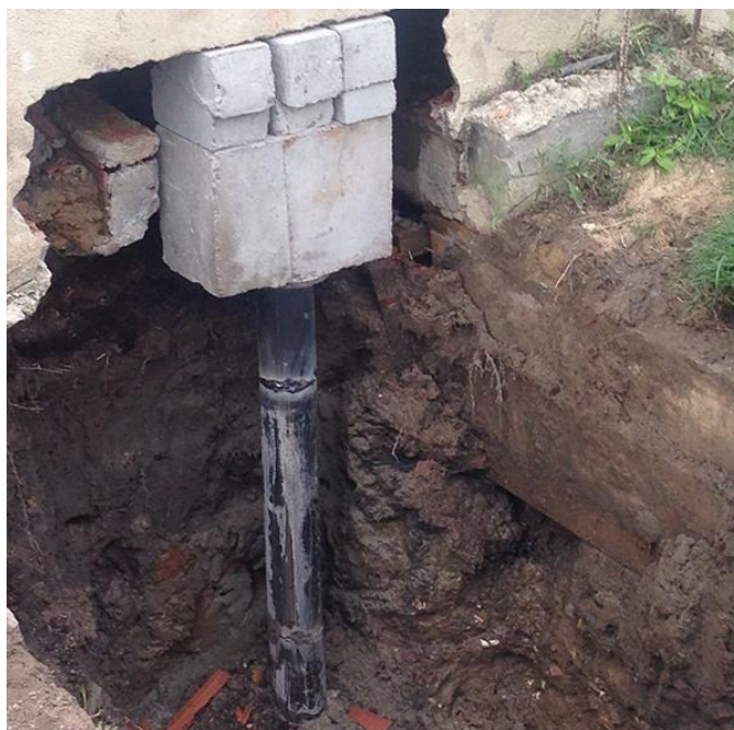
Figura 7 – Estaca Mega metálica instalada.
