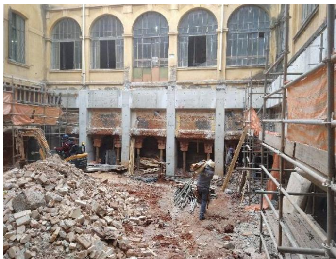
Figura 18 – Pilares do subsolo já executados, dando condição para a parte superior das estacas de reação serem removidas com segurança.
