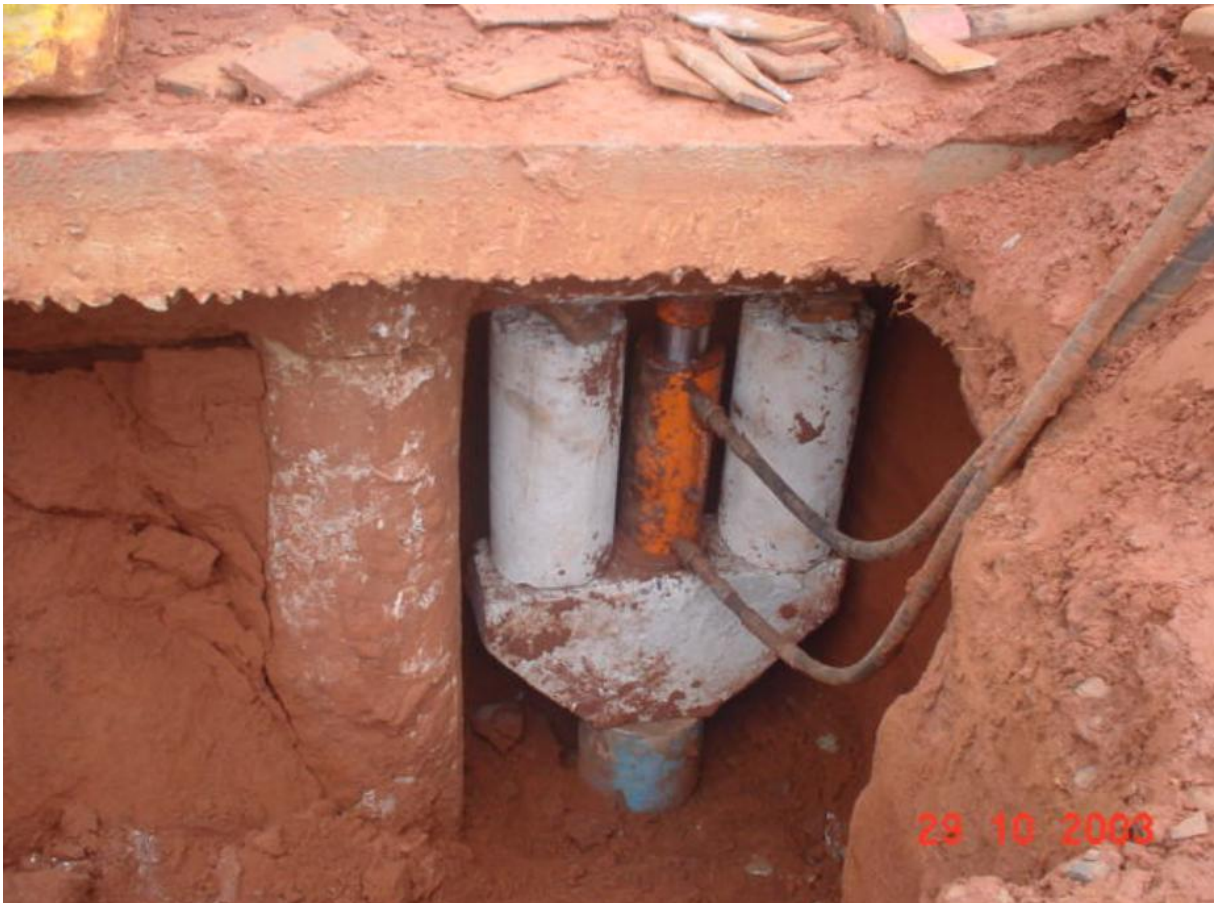
Figura 5 - Estaca Mega de concreto instalada.
