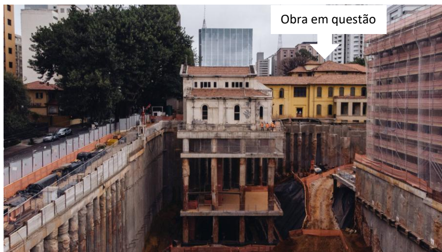
Figura 12 – Vista geral da obra com a localização do objeto de estudo.
