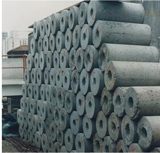
Figura 4 - Segmentos para estaca Mega de Concreto.
