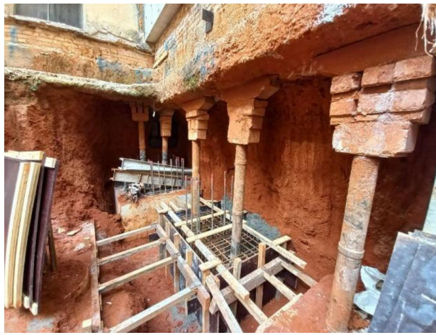
Figura 17 – Incorporação das estacas de reação em bloco de coroamento.
