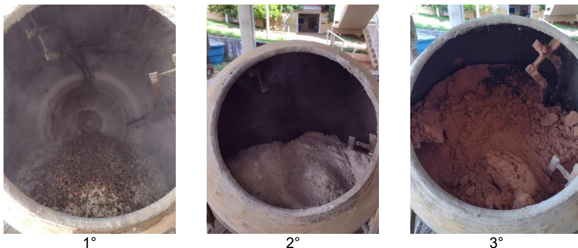
Figura 20. Sequência de colocação dos materiais na betoneira
