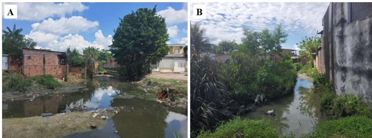
Figura 43 - A) Igarapé com ocupações em sua planície de inundação, assoreado e com restrição de fluxo decorrente de obra de canalização, sem identificação de localização; B) Moradias instaladas sobre igarapé local, com risco a inundações, sem identificação de localização.
