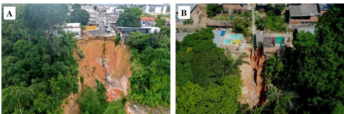
Figura 42 - A) Voçoroca ocasionada pelo fluxo concentrado de águas em direção à encosta, sem identificação de localização; B) Erosão ocasionada pela concentração das águas pluviais e servidas, sem identificação de localização.
