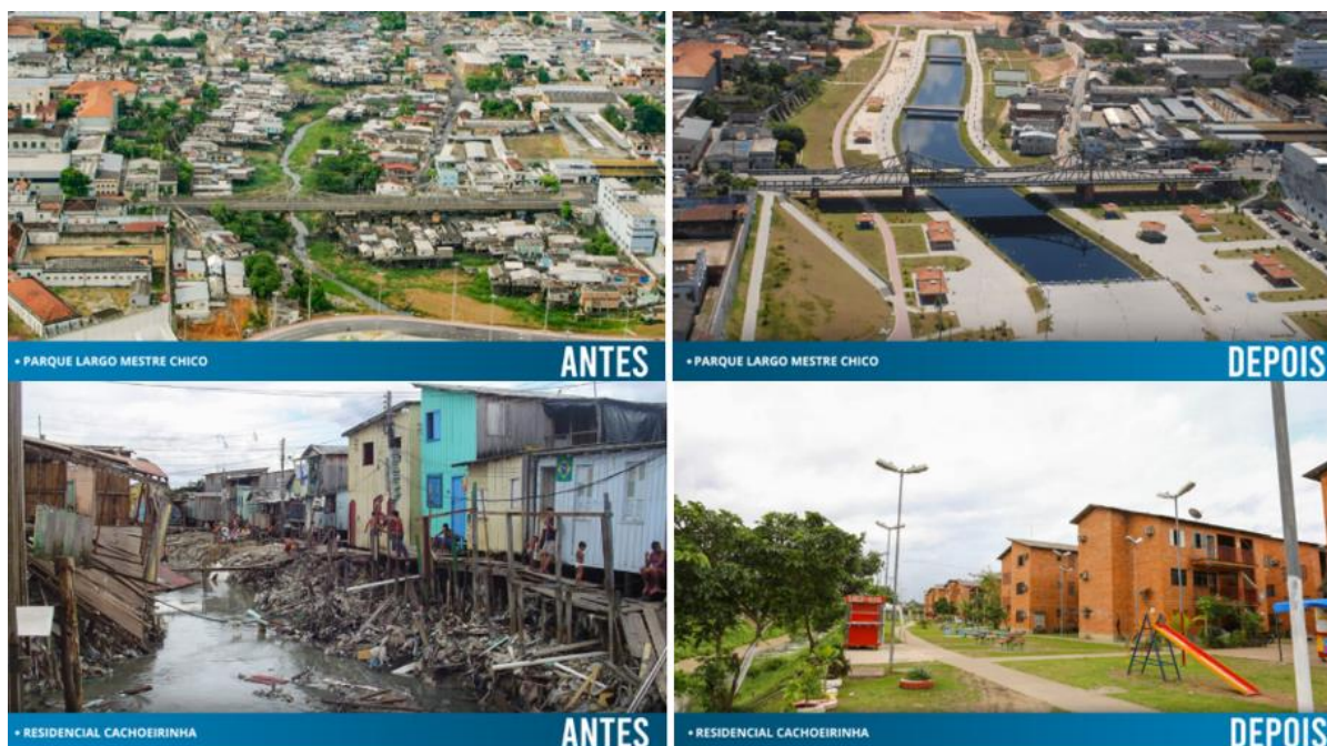
Figura 26 - Registros fotográficos de intervenções realizadas no âmbito do PROSAMIM às margens de igarapés na região central de Manaus-AM.
